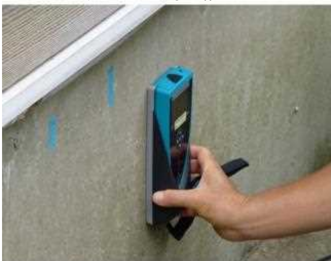
基礎配筋の調査
