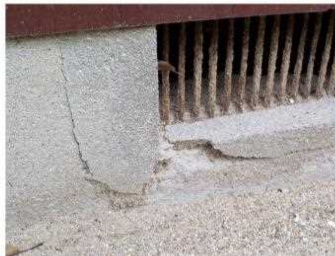
基礎立ち上がりの割れ
