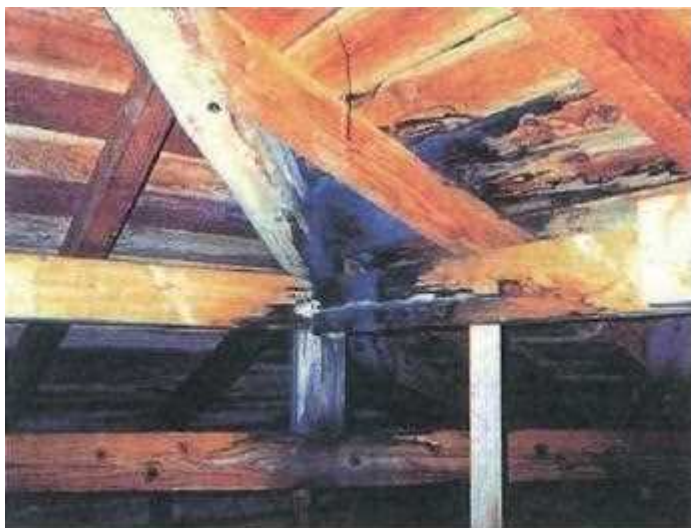
小屋組の漏水跡
