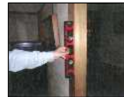
水平器による柱の傾きの計測
