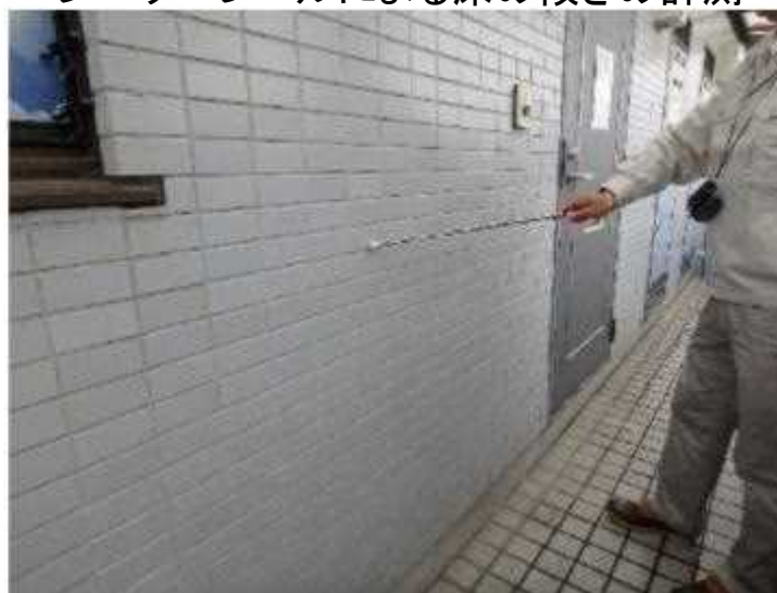
打診棒によるタイルの浮きの調査
