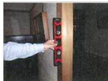
水平器による柱の傾きの計測
