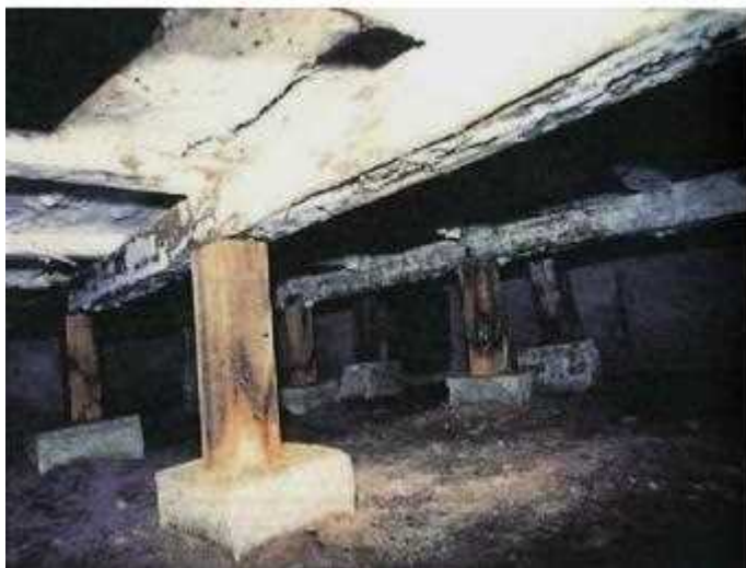
床下の木材の腐朽
