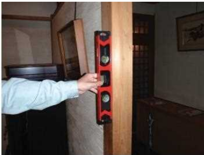
水平器による柱の傾きの計測
