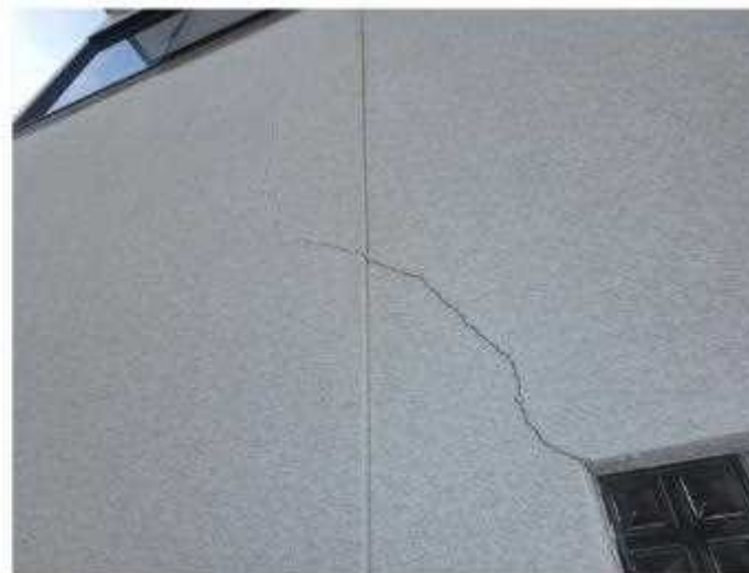
外壁のひび割れ
