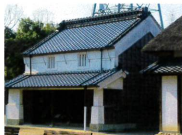
旧綿貫家住宅
